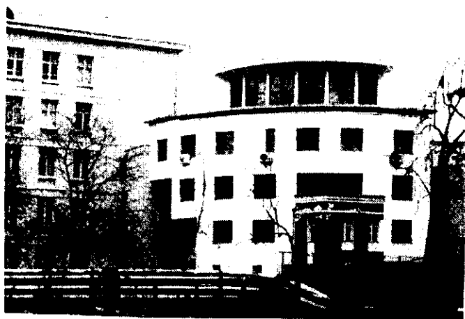
Пристройка к зданию школы (Москва, Вспольный пер., 6)
