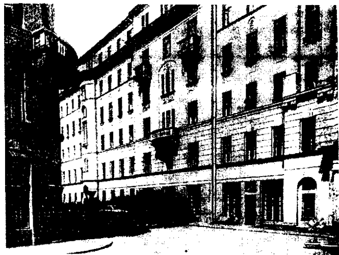
Уличный фасад комплекса доходных домов Московского купеческого общества на у.Солянка, Москва. Архитекторы В.Шервурд, Н.Герман, А.Сергеев, 1912-1915 гг.
