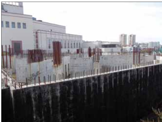
Рис. 1. Общий вид на существующие конструкции жилого дома
