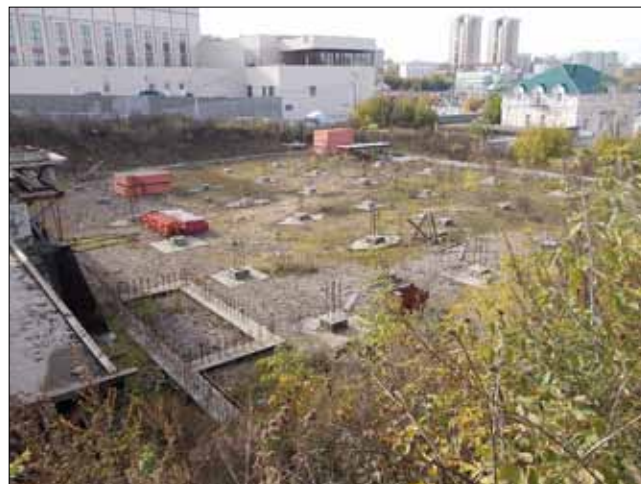
Рис. 2. Существующие конструкции паркинга
