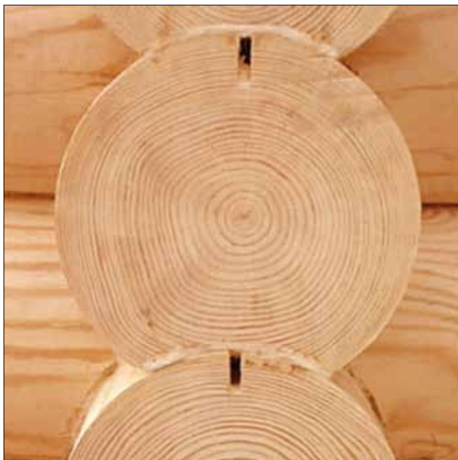
Рис. 1. Фрагмент ограждающей конструкции из оцилиндрованных бревен
