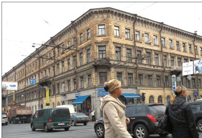
Рис. 1. Доходный дом на углу Садовой и Гороховой улиц в Санкт-Петербурге
