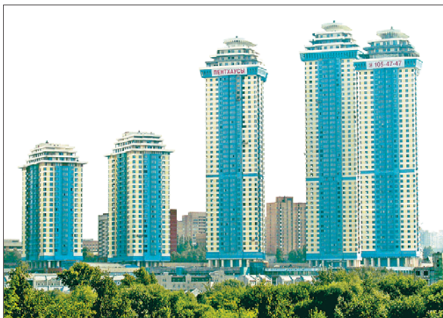
Жилой комплекс «Воробьевы горы» ООО «Дирекция капитального строительства»
