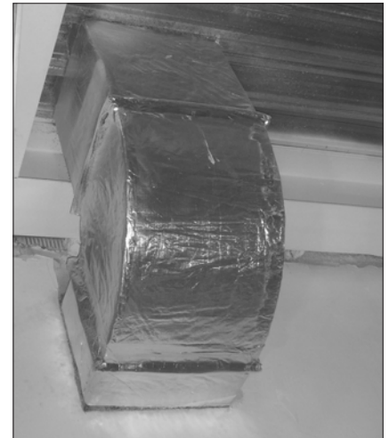
Рис. 3. Внешний вид воздуховода с огнезащитным базальтовым покрытием Изовент (Е1 60)
