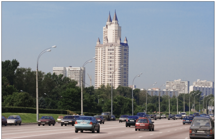
Рис. 2. Вид здания со стороны Кутузовского проспекта.
