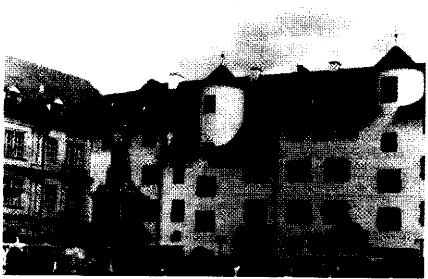
Дом на рыночной площади. Прием врезки цилиндров в накладную плоскость крыши
