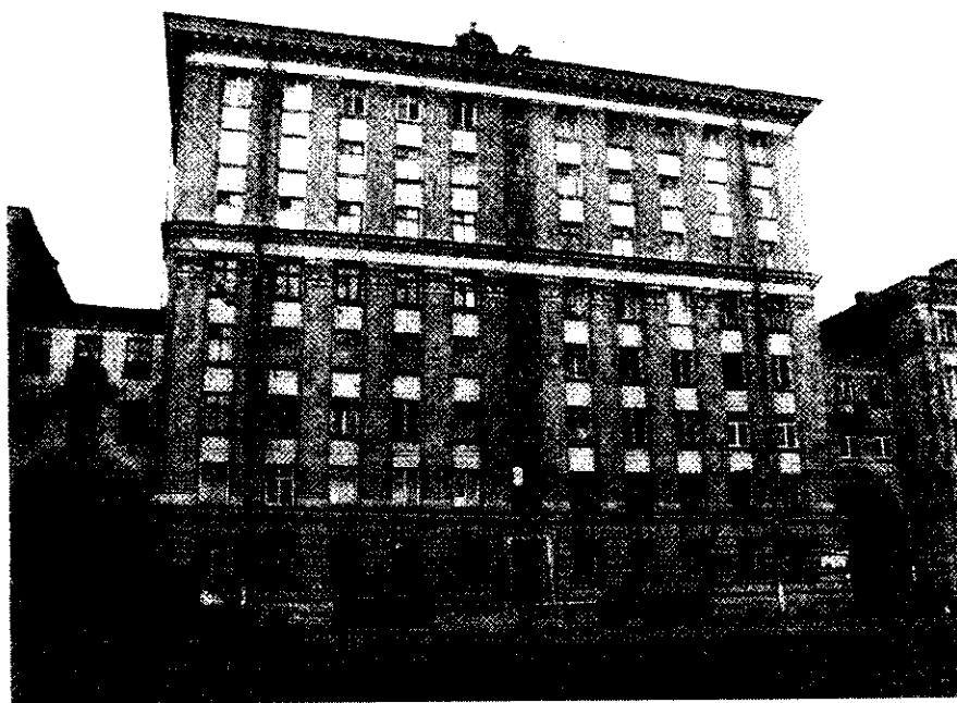
Рис. 8. Жилой дом по ул.Полярников (архитектор Г.И.Александров)
