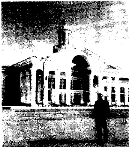
Челябинск. Реконструированное здание аэровокзала
