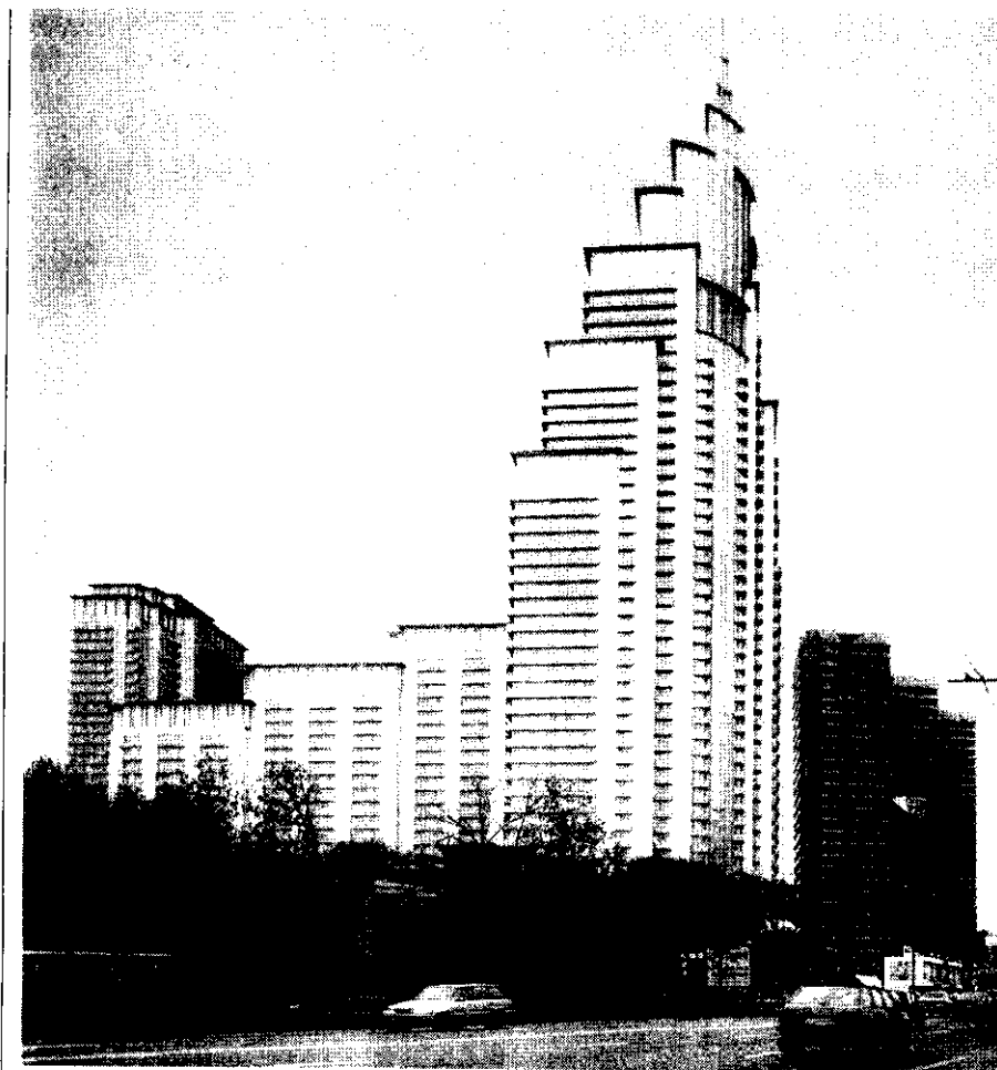
Москва. Многофункциональный жилой комплекс на Дмитровском шоссе (Авторский коллектив А.В.Кузьмин, В.М.Острецов, А.Н.Горелкин, В.В.Ходнев, Л.Б.Гендельман, А.Б.Вознюк)
