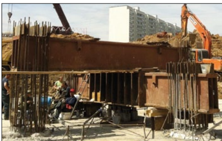
Рис. 9. Подготовка стенда для испытания сваи
