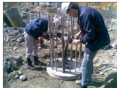
Рис. 10. Контроль сплошности свай методом Sonic
