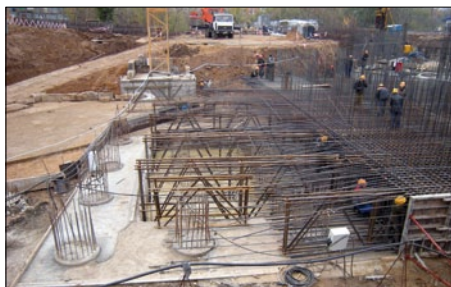
Рис. 8. Возведение фундаментных конструкций высотной части комплекса
