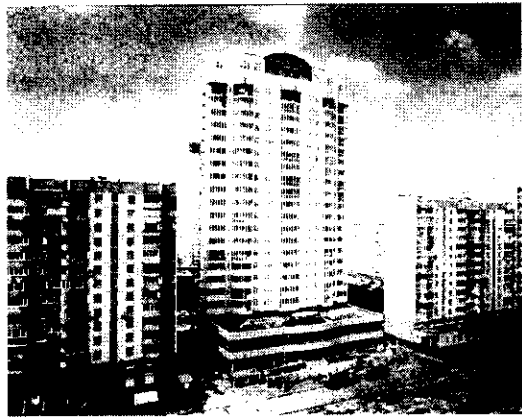
Монолитный жилой дом (Новочеремушкинская ул.)
