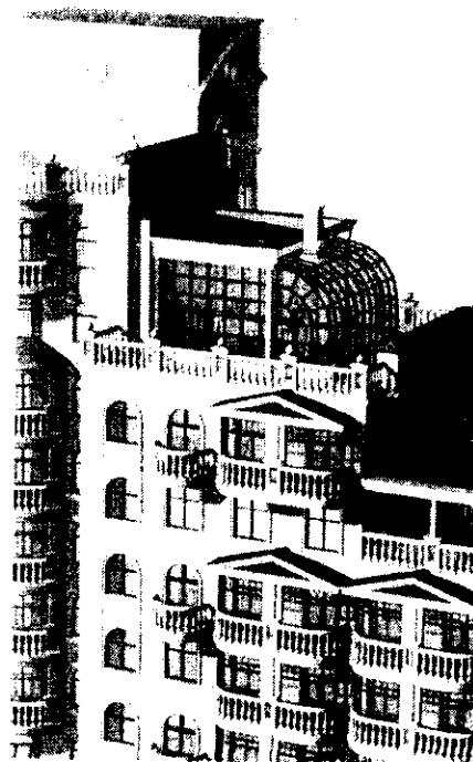
Пример устройства веранды на крыше (Краснопролетарская ул.)
