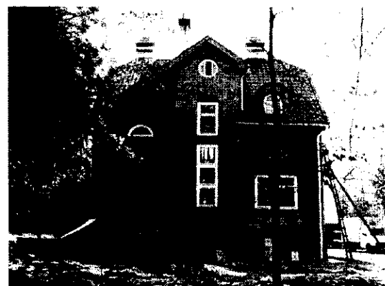
Двухэтажный дом из монолитного пенобетона а — на стадии строительства; б — фасад готового дома
