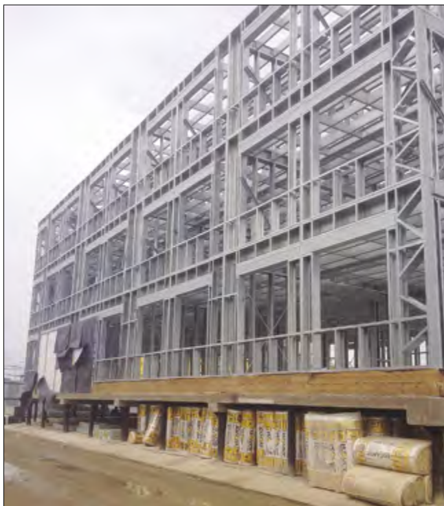
Рис. 6. Каркас офисного здания из ЛСТК в г. Якутске
