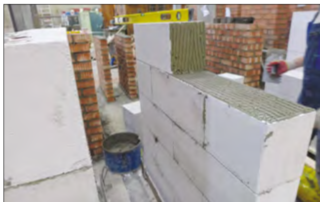
Рис. 4. Процесс изготовления образцов III серии
