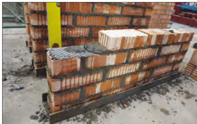
Рис. 2. Процесс изготовления образцов I серии
