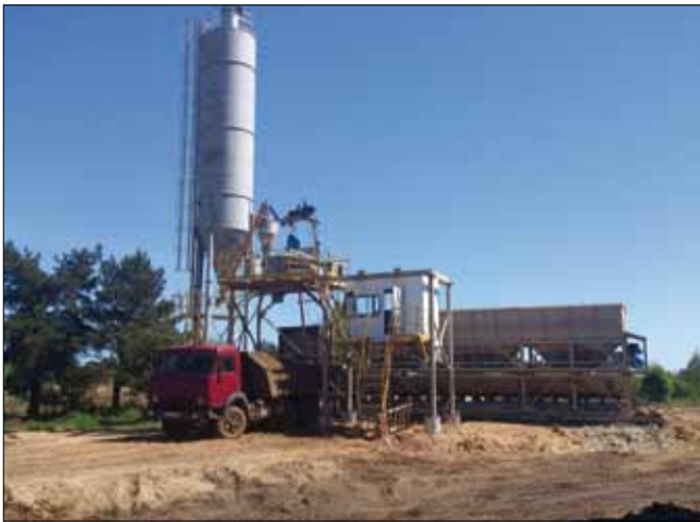
Рис. 1. Быстровозводимый завод по производству бетона
