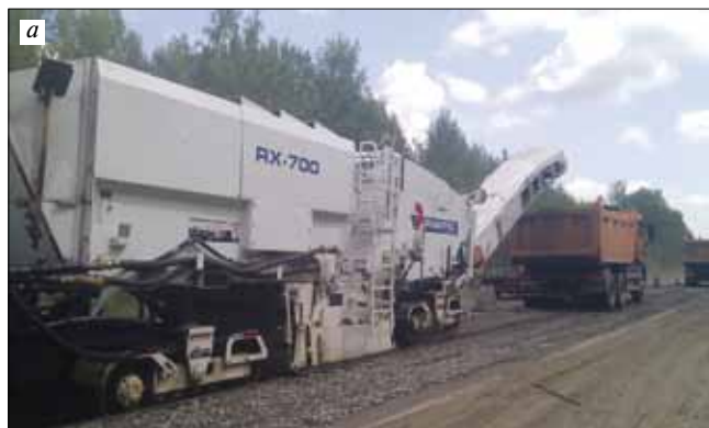
Рис. 1. Производство работ по технологии холодного ресайклинга: а – Россия, Калужская обл., 2012 г.; б – США, штат Виргиния, 2012 г.
