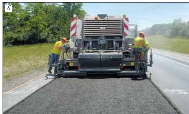
Рис. 1. Производство работ по технологии холодного ресайклинга: а – Россия, Калужская обл., 2012 г.; б – США, штат Виргиния, 2012 г.
