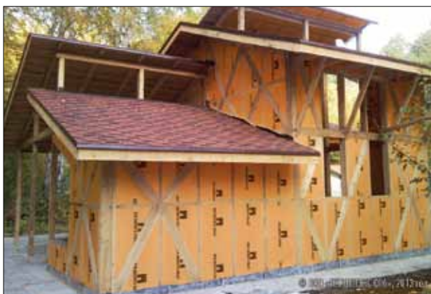
Рис. 3. Каркасный дом, утепленный плитами ПЕНОПЛЭКС СТЕНА®
