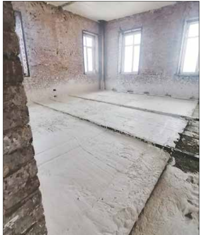
Рис. 6. Процесс заливки пеногипса в конструкцию перекрытия первого этажа Fig. 6. The process of pouring foam gypsum into the structure of the first floor
