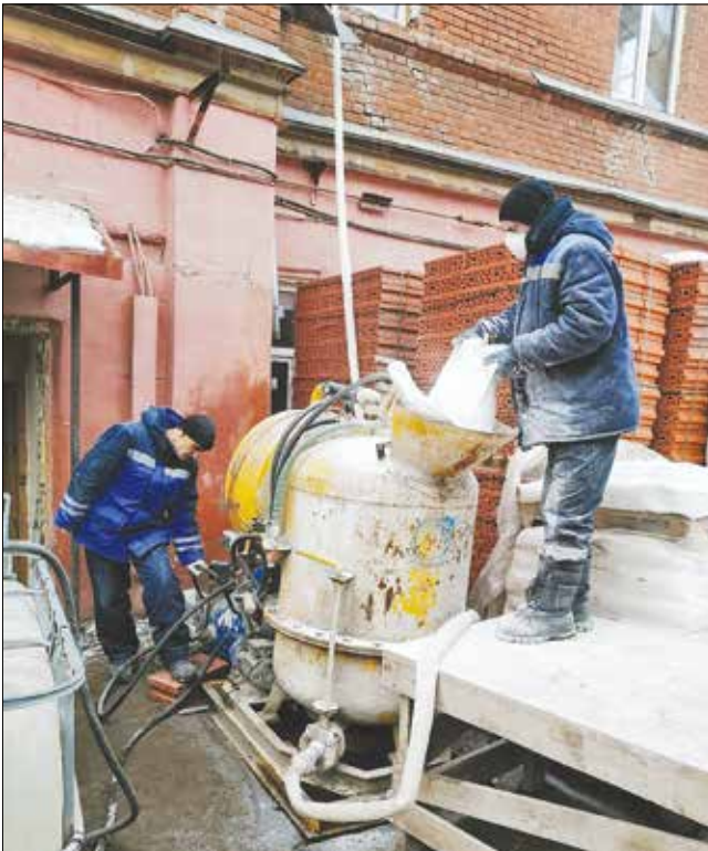
Рис. 4. Установка для приготовления пеногипса (размещалась в зимний период на улице рядом с объектом) Fig. 4. The machine for making foam gypsum (placed in the street next to the object in winter)
