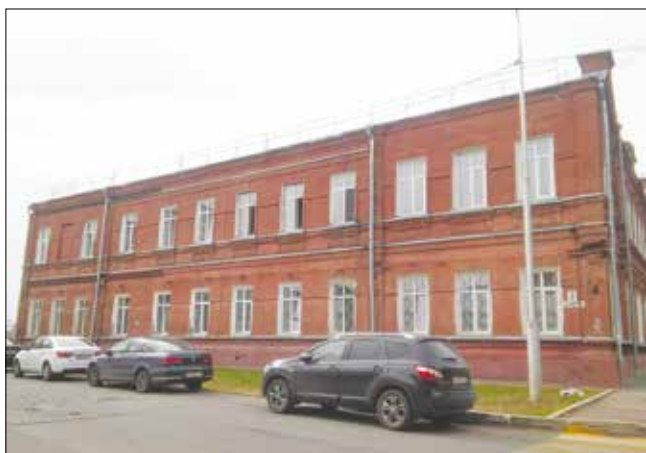
Рис. 1. Здание Госпиталя ветеранов войн по ул. Тукаева в г. Уфа (часть здания, подлежащая капитальному ремонту)
