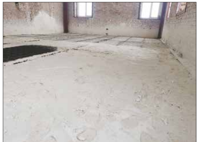
Рис. 7. Завершение технологического процесса заливки монолитного пеногипса в конструкцию перекрытия первого этажа (перед устройством цементно-песчаной стяжки) Fig. 7. Completion of the technological process of pouring monolithic foam gypsum into the floor structure of the 1st floor (before the installation of the cement-sand screed)
