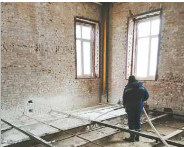
Рис. 5. Начальный этап заливки пеногипса в конструкцию перекрытия первого этажа (работы выполнялись в зимний период) Fig. 5. The initial stage of pouring foam gypsum into the structure of the first floor overlap (work was carried out in winter)
