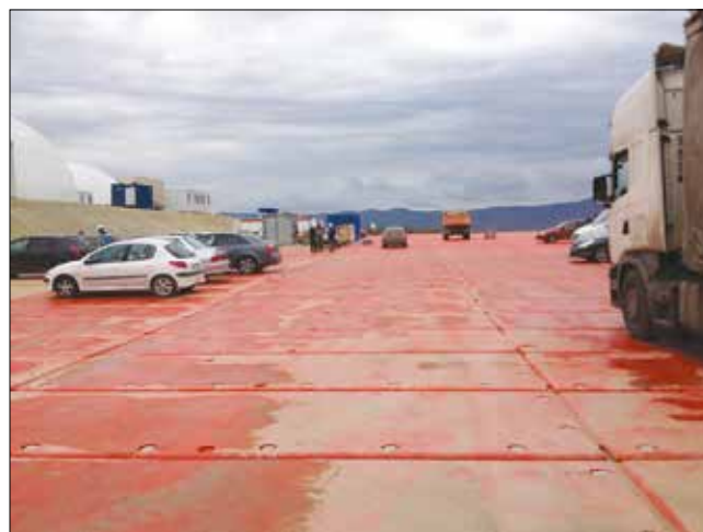
Рис. 4. Площадка из мобильных дорожных пластиковых плит Fig. 4. Playground from mobile road plastic plates
