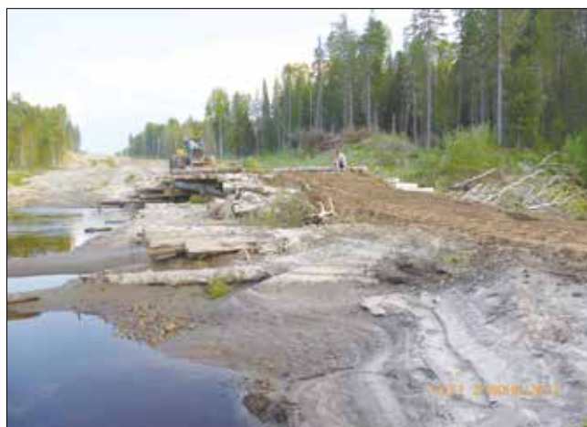
Рис. 3. Устройство лежневки на лесовозной дороге на подходе к водопропускному сооружению
