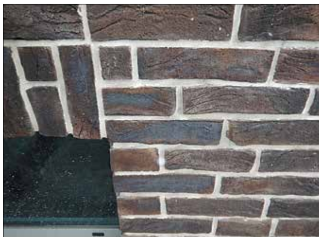
Рис. 6. Металлизированный оттенок на поверхности кирпича темного цвета за счет реакций оксидов марганца после трех лет эксплуатации Fig. 6. Metallized tint on dark brick surface by manganese oxide reactions after three years of operation
