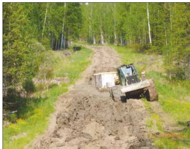
Рис. 5. Просадка сланей в глинистых грунтах старой лесовозной дороги Fig. 5. Shale sump in clay soils of the old logging road
