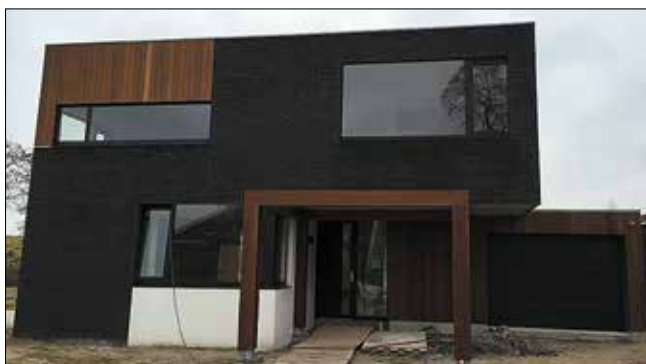
Рис. 1. Фасад здания с фрагментами из черного кирпича и раствора Fig. 1. Building facade with black brick and mortar fragments
