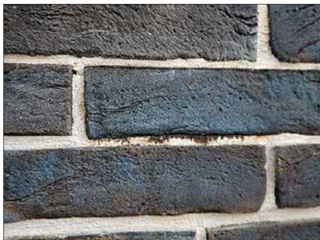
Рис. 6. Металлизированный оттенок на поверхности кирпича темного цвета за счет реакций оксидов марганца после трех лет эксплуатации Fig. 6. Metallized tint on dark brick surface by manganese oxide reactions after three years of operation
