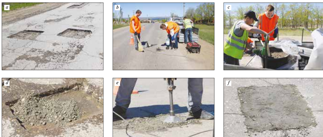
Рис. 2. Технология выполнения работ: a – состояние дорожного покрытия с вырубленными картами; b – увлажнение водой карты ремонта; c – отбор ремонтной смеси из емкости; d – распределение ремонтной смеси в карте; e – уплотнение ремонтной смеси; f – результат ремонта Fig. 2. Technology of work: a – the state of the road surface with holes; b – water moistening of holes; c – selection of repair mixture from the tank; d – is the distribution of the repair mixture in holes; e – compaction of repair mixture; f – repair result
