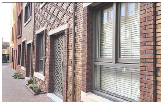
Рис. 2. Использование клинкерного кирпича на фасадах зданий Fig. 2. Use of clinker bricks on building elevations
